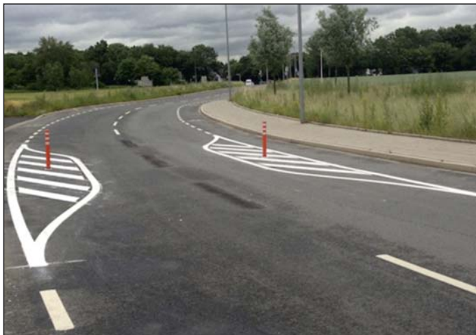
Slika 22. Obostrano suženje kolnika, oblikovano vodoravnom prometnom signalizacijom i prometnom opremom u obliku stupića, kao mjera za smanjenje brzine kretanja vozila
