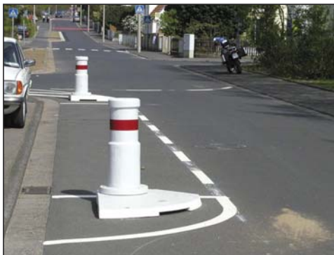
Slika 21. Suženje kolnika na jednoj strani, oblikovano vodoravnom prometnom signalizacijom i prometnom opremom u obliku stupova, kao mjera za smanjenje brzine kretanja vozila
