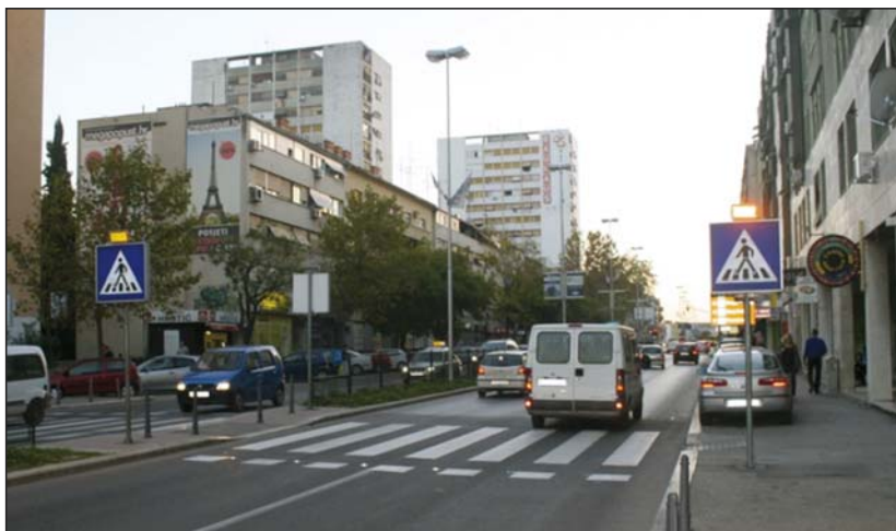
Slika 10. Pješački prijelaz s ugrađenim bljeskalicama u asfaltu, svjetlećim prometnim znakovima C02 – „obilježen pješački prijelaz“ i bljeskalicama iznad prometnih znakova u Splitu, Ulica Domovinskog rata
