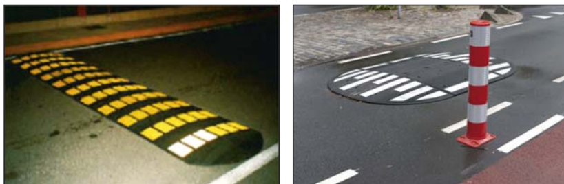
Slika 17.-18. Umjetne izbočine od gume ili plastične mase
