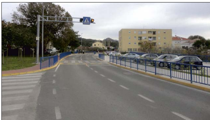
Slika 15.-16. Ograde za zaštitu pješaka i usmjeravanja prometa pješaka na obilježene pješačke prijelaze (visina ograde je 1.10 m) s istaknutim pješačkim prijelazima pomoću podloge žute boje
