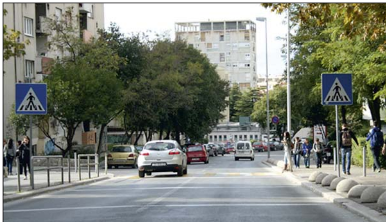
Slika 12. Pješački prijelaz sa žutom podlogom i obostrano postavljenim prometnim znakovima C02 – obilježen pješački prijelaz i optičkim bijelim crtama upozorenja na kolniku
